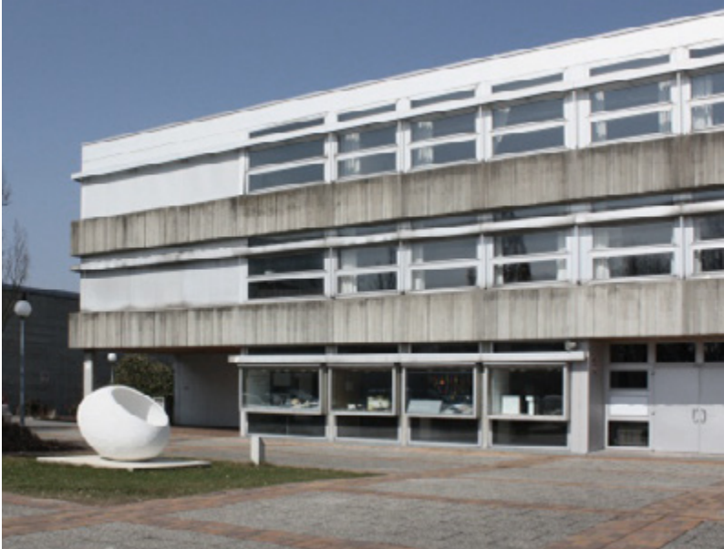
Zur Erinnerung: Gebäude S1 vor der Sanierung
