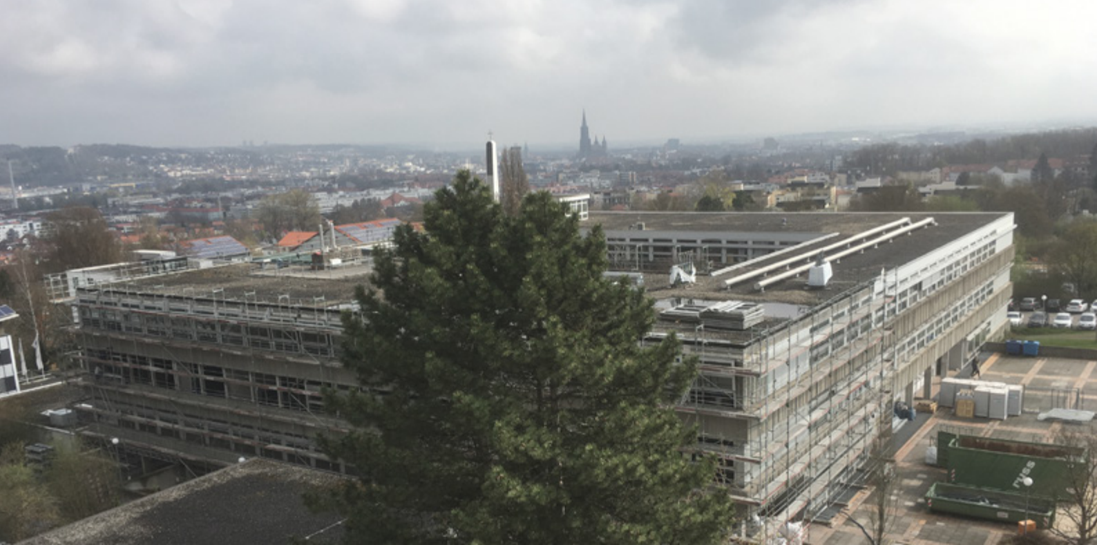
Unser Sanierungsobjekt Gebäude S1 (Blick vom Dach des Gebäudes B1 der Robert-Bosch-Schule)
