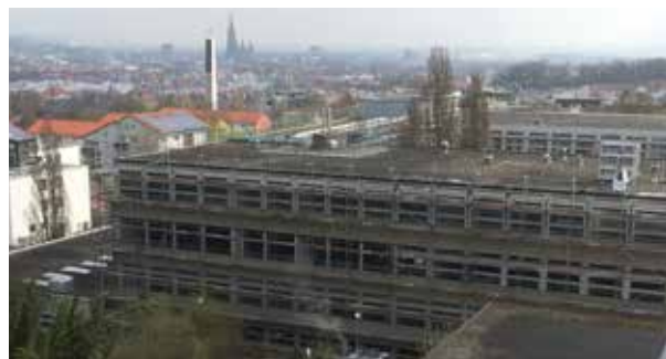
Baustelle des Gebäudes S1, Blick vom Dach des Gebäudes B1 der Robert- Bosch-Schule
